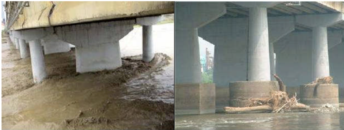
桥墩被流水及其它物质冲刷示意图
